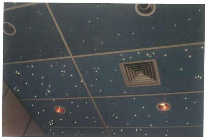
**Figura 4** Vista do teto após a aplicação do efeito céu estrelado com fibra ótica. [Fotografia de FASA Fibra Ótica]
